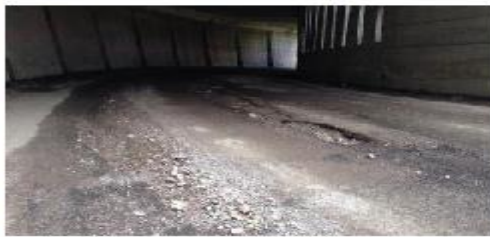
L'asfalto traforato sotto una galleria dell'arteria
